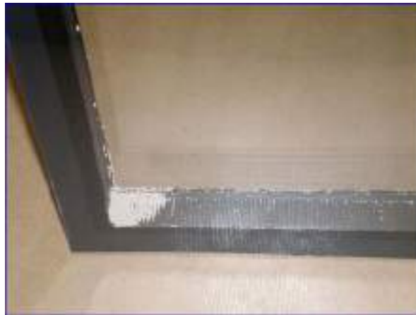
Figure 15 : Présence anormale de grains de dessicant entre les feuilles de verre.
