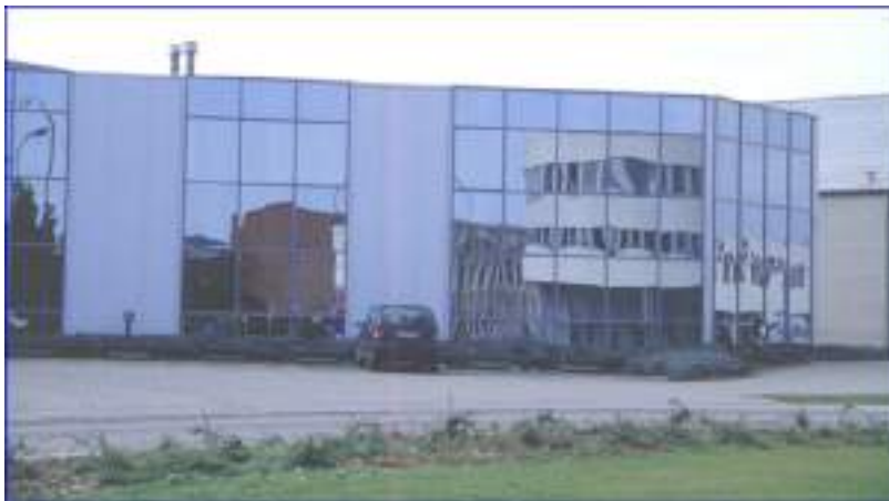
Figure 21 : Reflet déformé.
