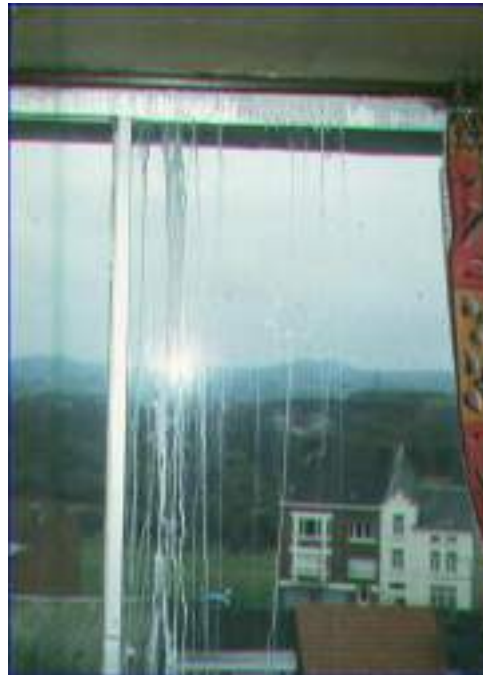
Figure 27 : Coulées sur le verre.
