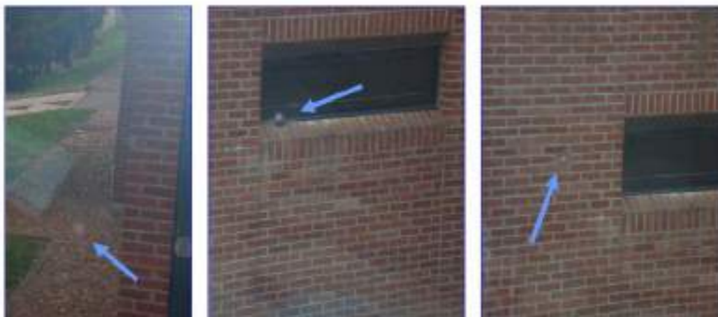
Figure 3 : Inclusion vue selon différents angles (avec halo).
